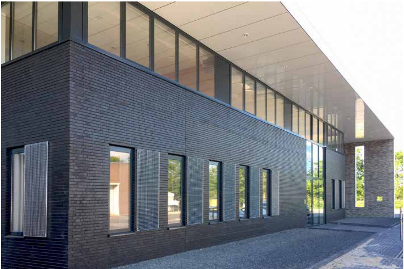
De luifel in Ruinerwold is voorzien van een witte boelbord.
