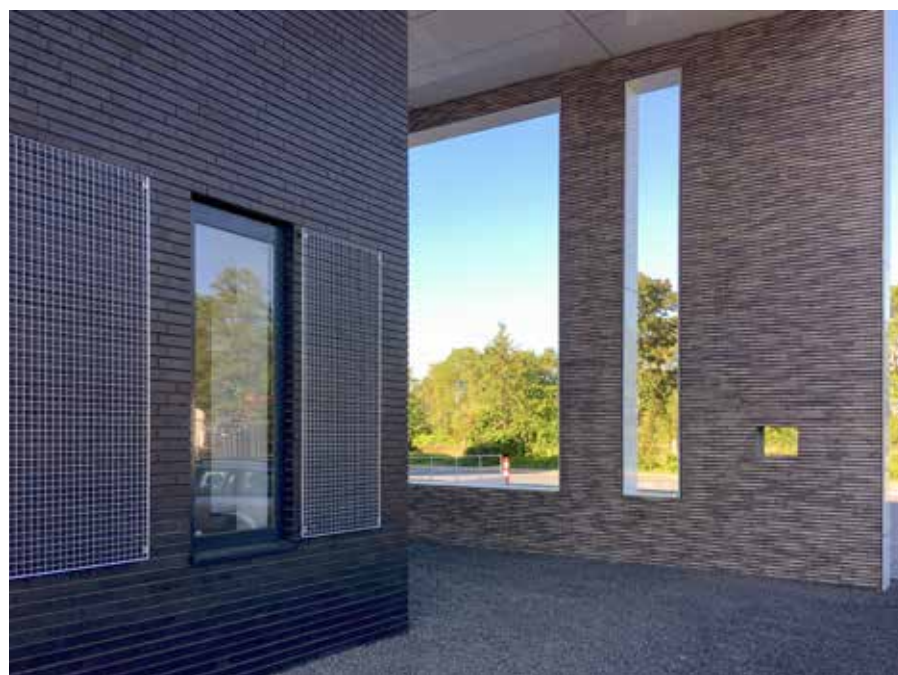
De gevel is uitgevoerd in een zwarte baksteen met verdiepte voeg. Het rooster van de zonwerende luifel van Twello komt hier terug als raamluiken.
